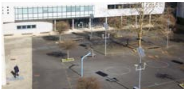
Photo d'avant les travaux
